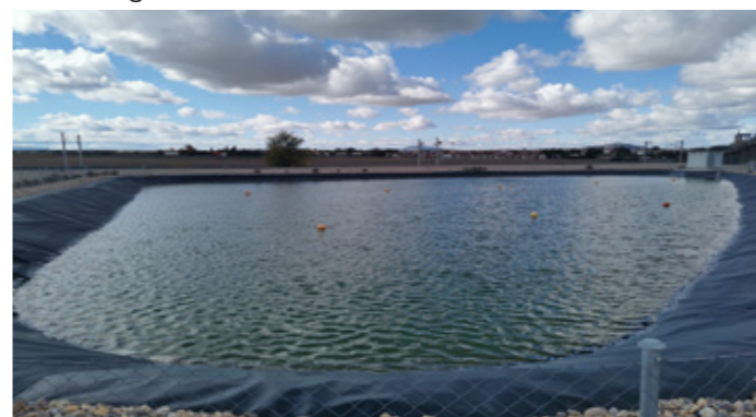
Balsa de recogida de aguas pluviales.
